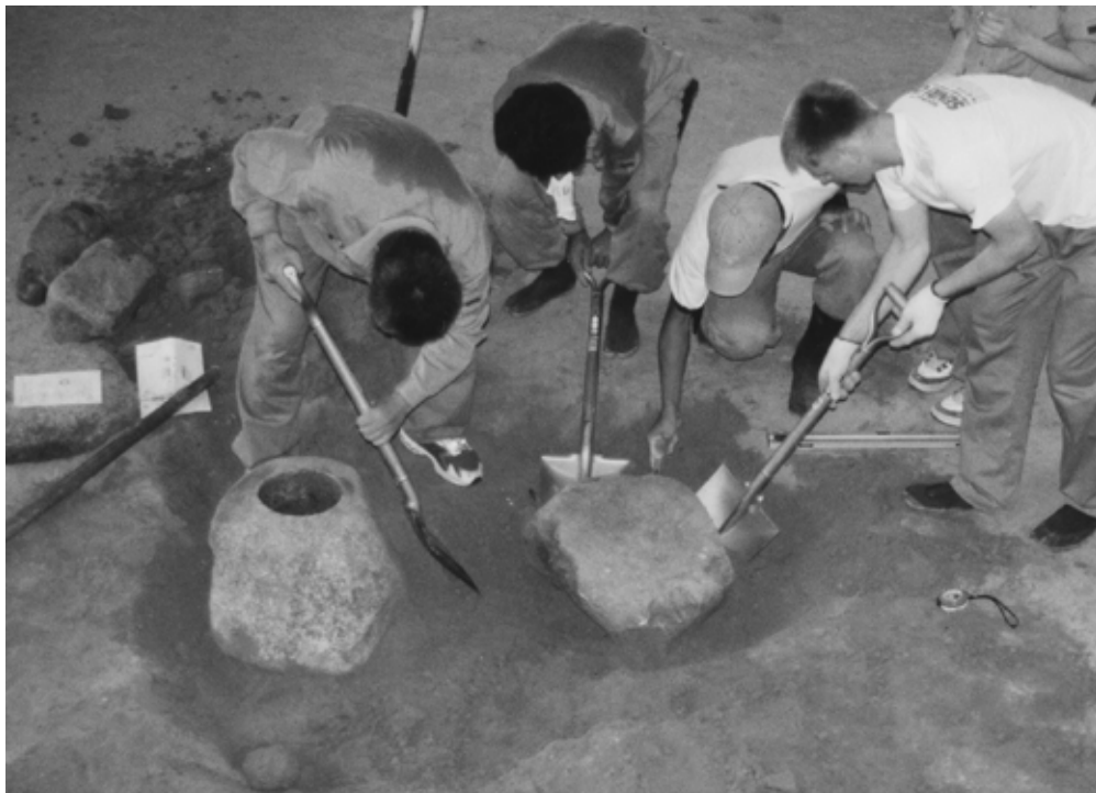
Фото 8. Установка цукубаи при участии стажёра из ВГУЭС на практических занятиях в Международном колледже ремесла и искусства, преф. Тояма, Япония, сентябрь 2002 г.: (слева) сосуд для воды, (справа) камень маэиси. Источник: из архива Мостового С.А.
