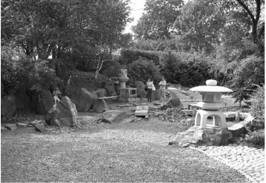
Фото 5. Сад дружбы во время реконструкции пьедестального каменного фонаря и каменного моста, август 2010 г. Источник: фото Мостового С.А.
